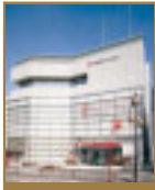
第2東急鷺沼ビル
