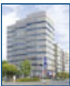
TOKYU REIT 木場ビル
