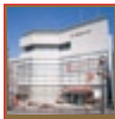
第2 東急鷺沼ビル
