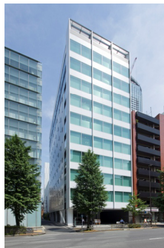
東急虎ノ門ビル
