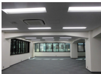
LED化、空調更新工事後内観 (TOKYU REIT八丁堀ビル)
