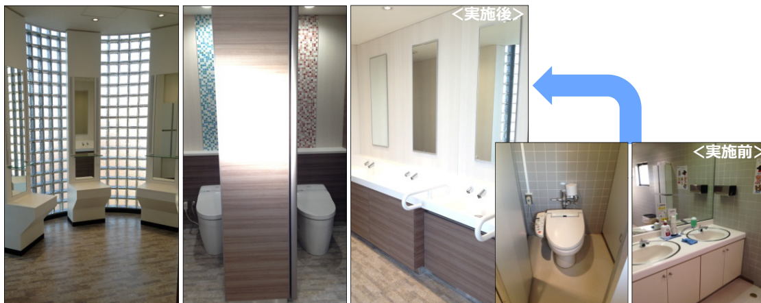
各階トイレ・給湯室の改修工事（東急池尻大橋ビル）
