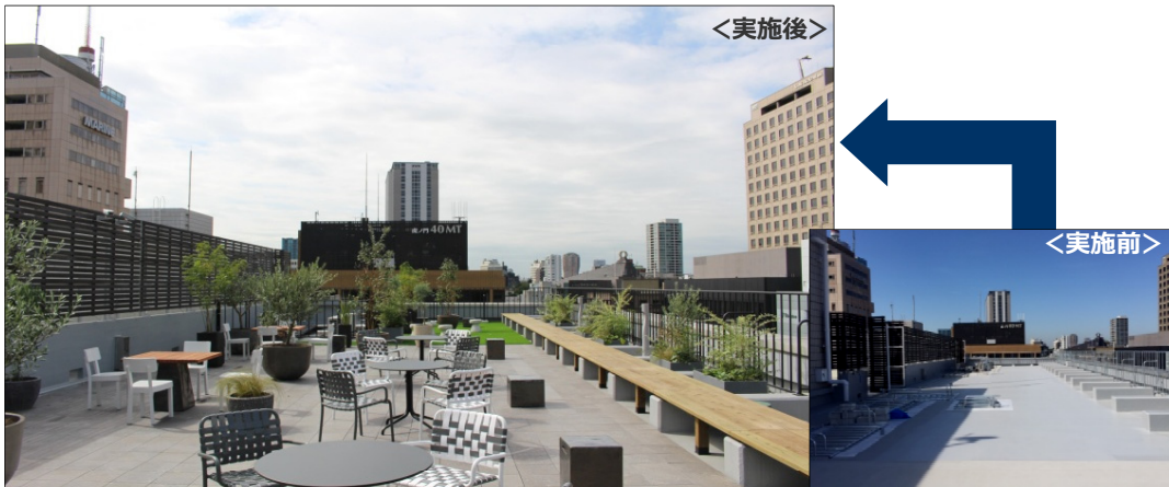
・2016年秋に屋上のリニューアル工事を実施、喫煙スペース及びリフレッシュスペースを設置
