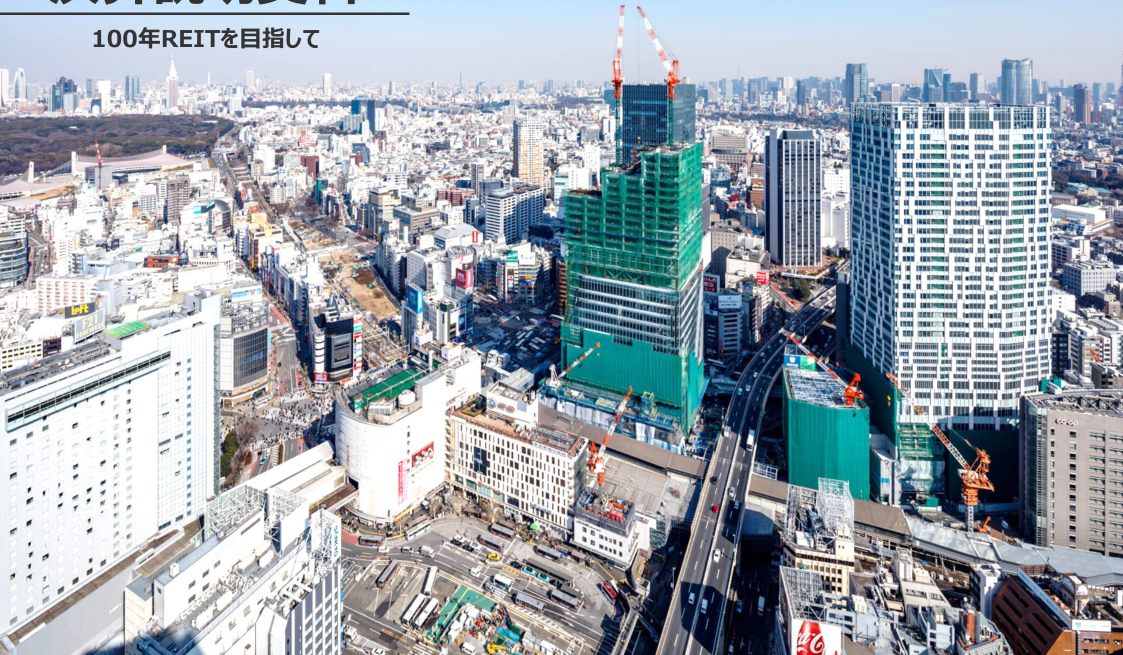
渋谷駅周辺再開発の状況（2018年2月撮影）
