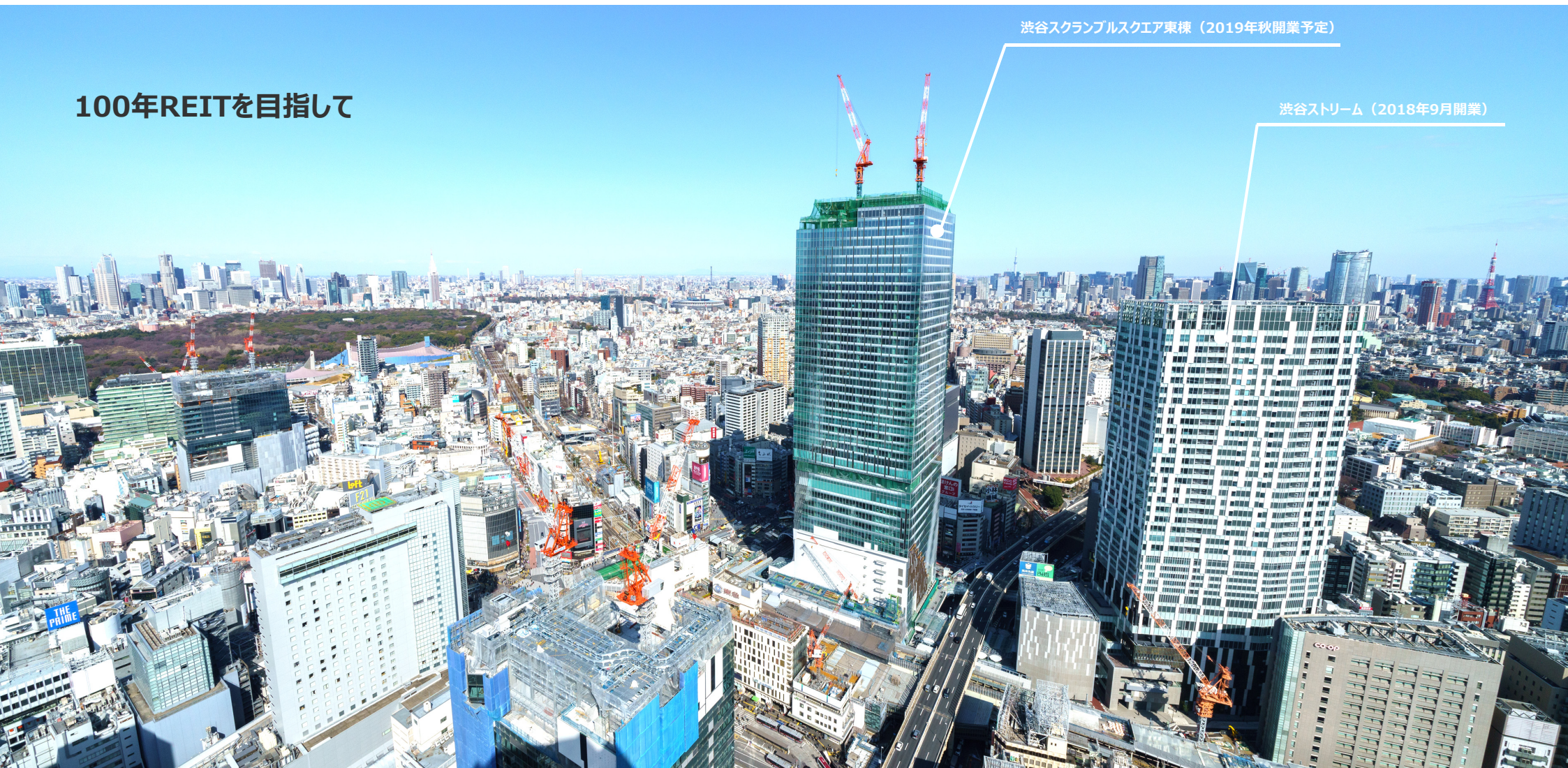
渋谷駅周辺再開発の状況（2019年2月撮影）
