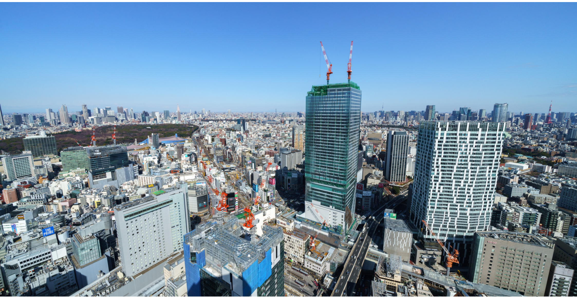
渋谷駅周辺再開発の状況（2019年2月撮影）
