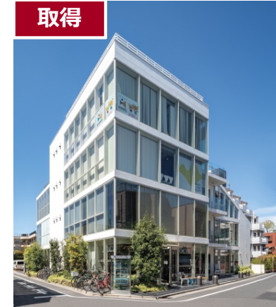
ユニゾ下北沢ビル (商業施設)
