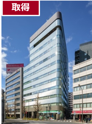
渋谷道玄坂スカイビル (オフィス)
