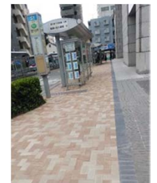
遮熱性インターロッキングの敷設（世田谷ビジネススクエア）
