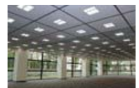
LED化工事後 (世田谷ビジネススクエア)
