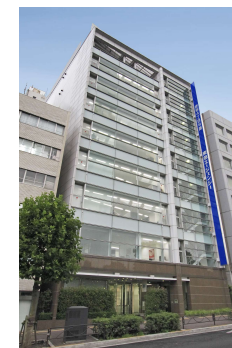
赤坂四丁目ビル (東急エージェンシー本社ビル) (オフィス)
