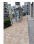
遮熱性インターロックの敷設（世田谷ビジネススクエア）
