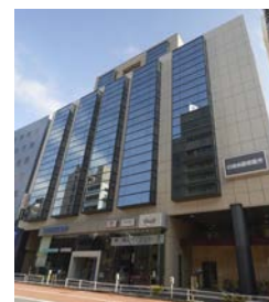
東京日産台東ビル
