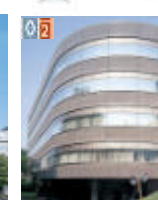
東急南平台町ビル
